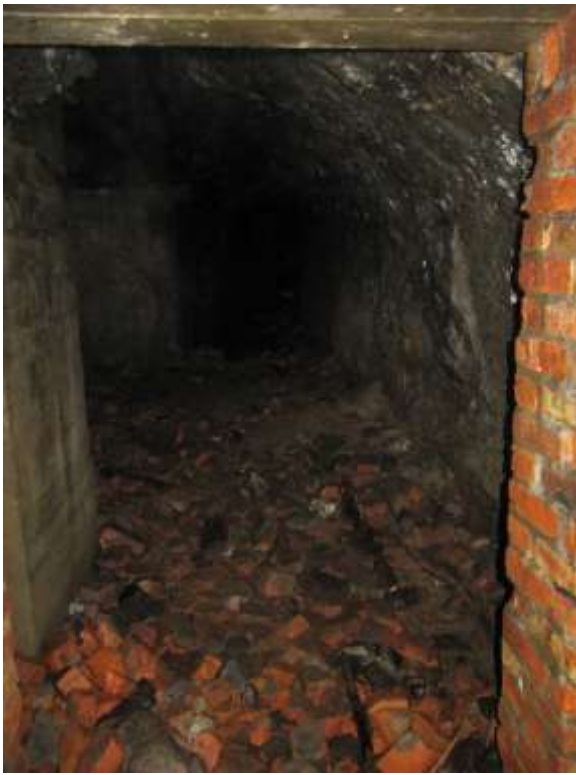
95B. Fra tunnelen ved Koåsbakken jan 2020
