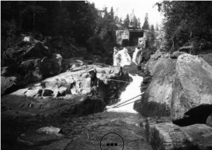
Damluka til venstre for fløting av tømmer. Bunnluka i den over åtte meter høye steindammen sikret maksimal vannreserve for Brukseierforeningen og byens befolkning.
