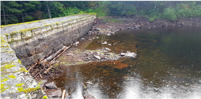
Bildet viser sannsynligvis rester av fundamenter for dammen fra 1869.
