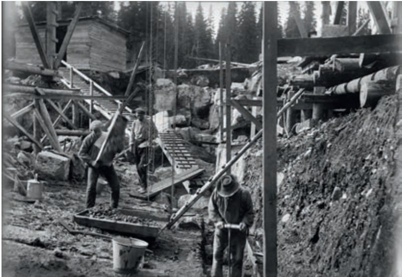
Arbeidere er i gang med grunnarbeidene for Gjerdingsdammen. Tungt, fysisk arbeid uten motoriserte hjelpemidler.
