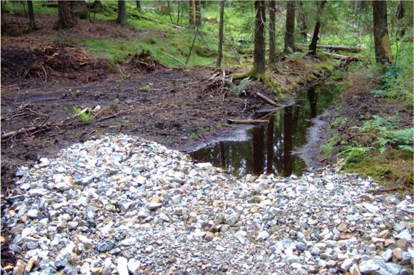
Figur 59. Det er bygget en rekke slike terskler i den grøfta myra sørvest for Griserud på Gjellebekk i 2009. Hver enkelt terskel gir en full oppdemming av vannet. Foto: Even W. Hanssen 2010.
