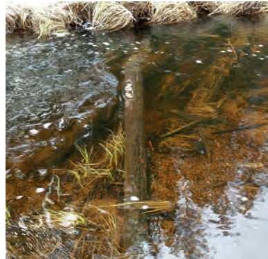
Rester av brua over Langdalselva (mai 2016)?
