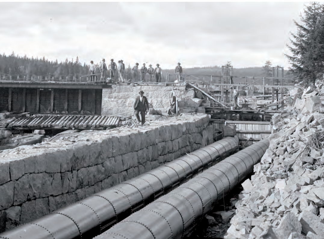
Slik så det ut da de la rørgate ut fra Skjærjødammen i 1899 ... FOTO: Oslo Lysverkers samling/Oslo byarkiv
