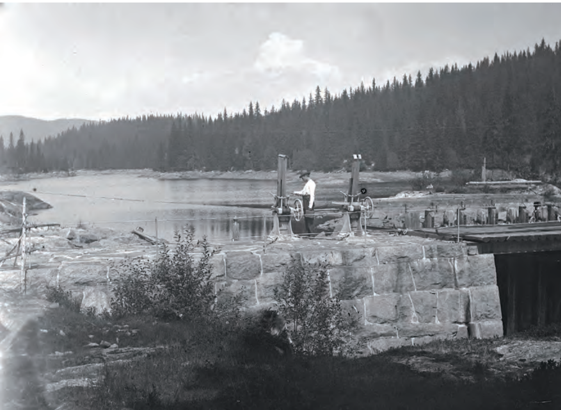
På Sandungen bygde brukseierne en ny, solid steindam. FOTO: Ukjent/Vann- og avløpsetaten
