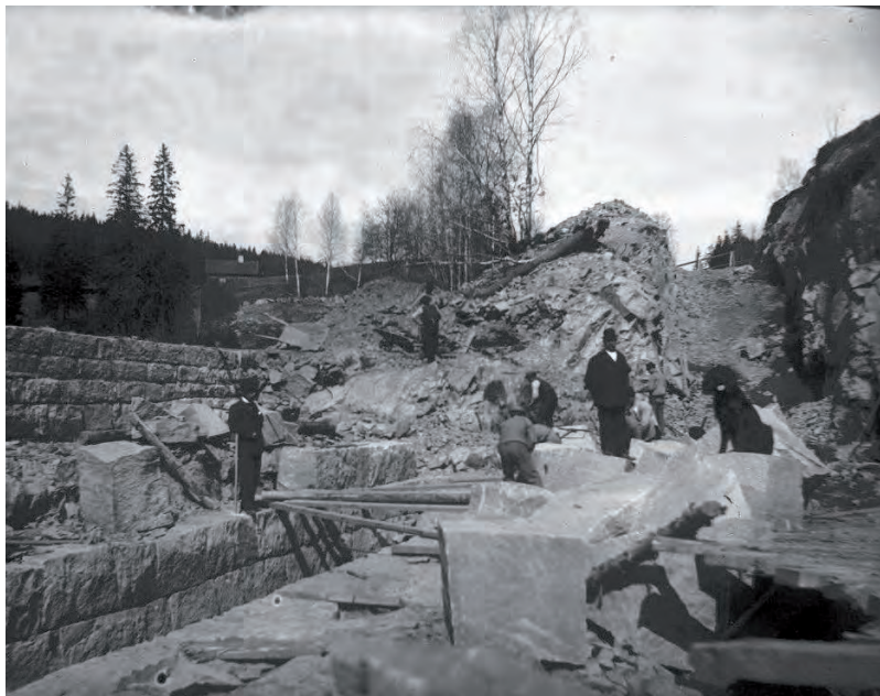
Her klargjøres grøfta for rørledningen i 1899. FOTO: Oslo Lysverkers samling/Oslo byarkiv
