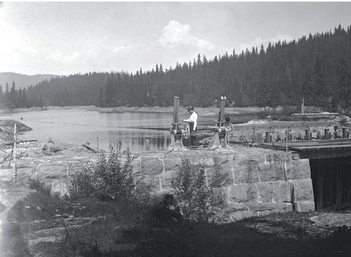
På Sandungen bygde brukseierne en ny, solid steindam. FOTO: Ukjent/Vann- og avløpsetaten
