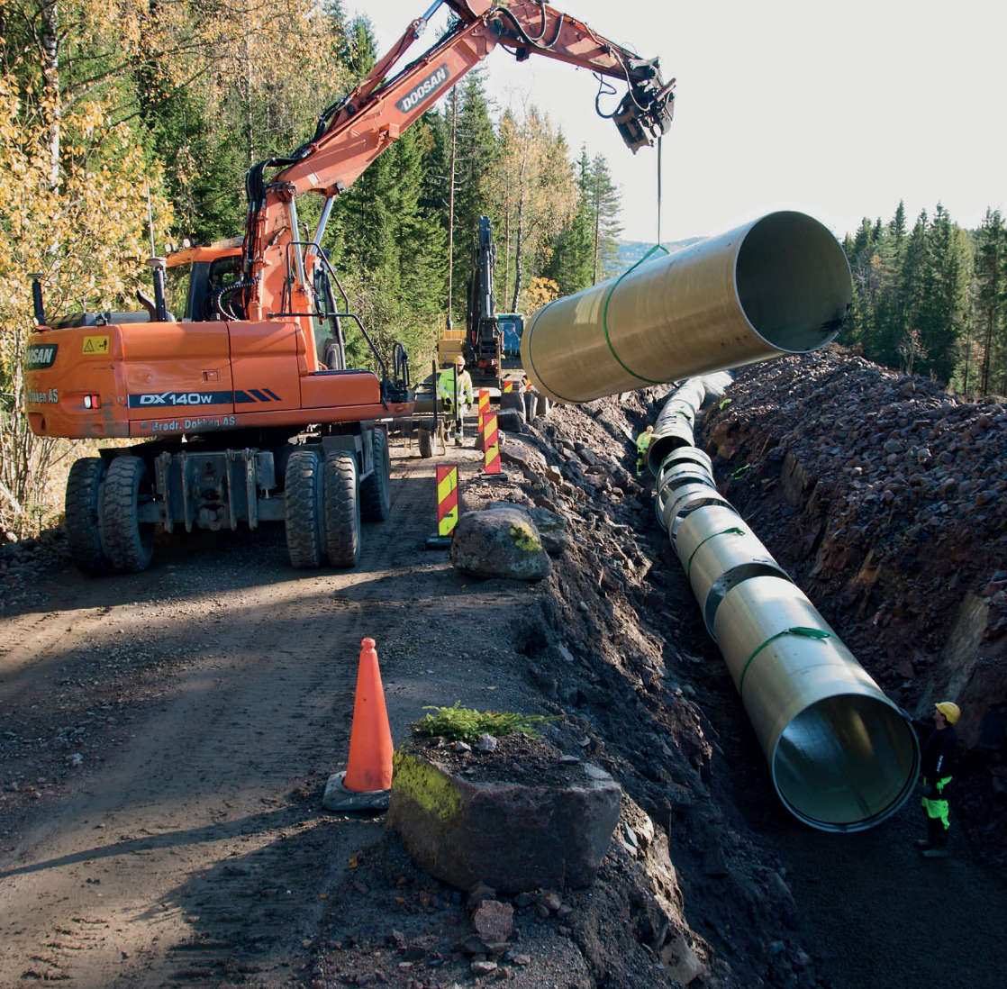
Sånn gjør vi i dag. Da ny rørgate ble lagt i 2014, var det maskinene som tok de tyngste løftene. FOTO: Rune Martinsen
