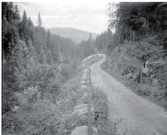
Brukseierne bygde veier og åpna Marka for folk flest. Her er et bilde fra den nye Greveveien i Almedalen mellom Movann og Ørfiske. FOTO: Ukjent/Oslo byarkiv
