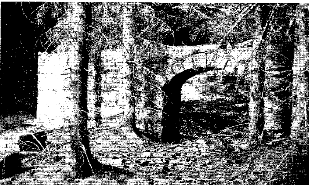
Grunnmur på Kirkebyvangen fra 1920.
