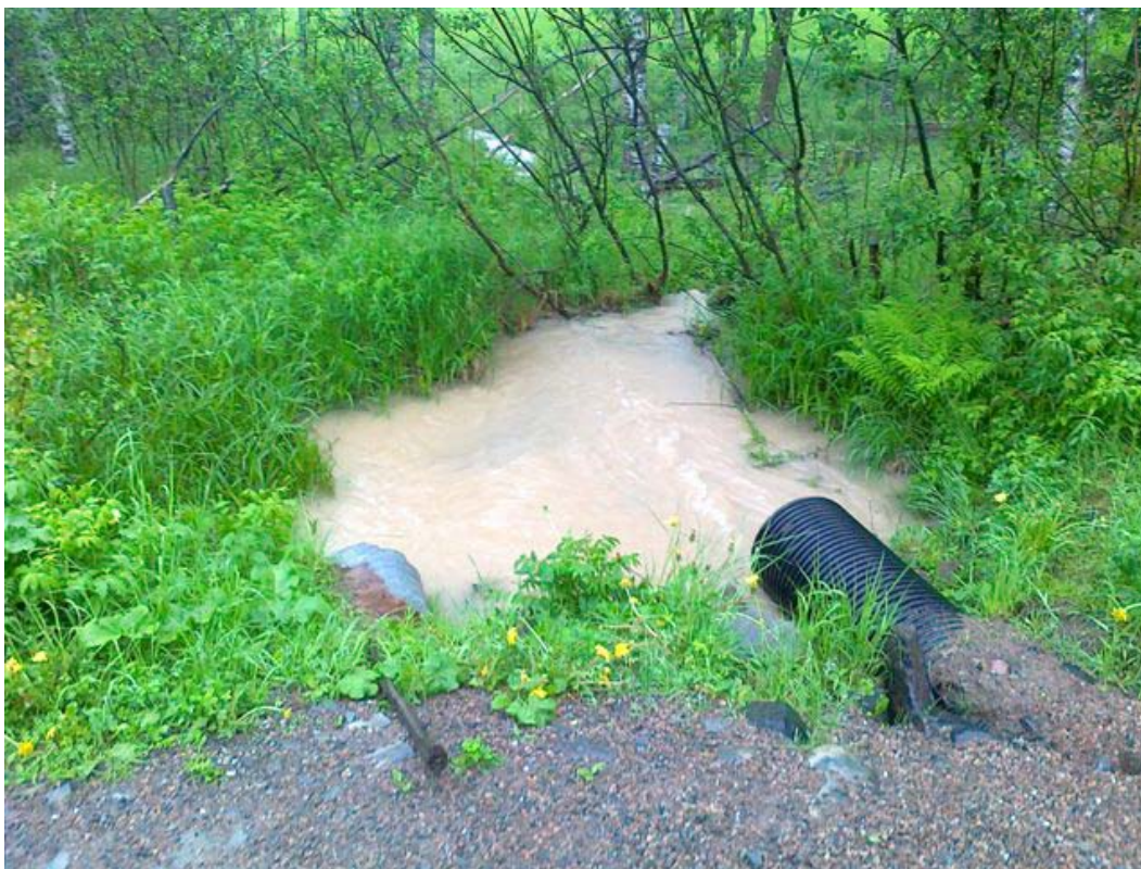
Figur 3-13. Skjærvenbekken nedenfor Låkeberget parkeringsplass
