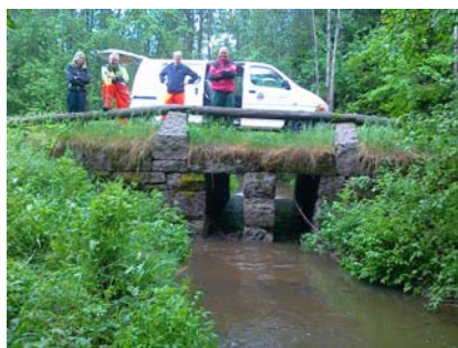
Lautabekken (svakt erosjonspåvirket)
