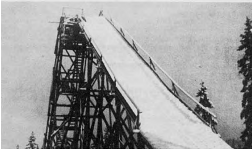
Året er 1952. Tjernbakken står ferdig på Sørbråten. Bjarne Hansen har akkurat satt de første spor ned det 12 meter høye stillaset. FOTO: Sørbråten ILs jubileumsbok.
