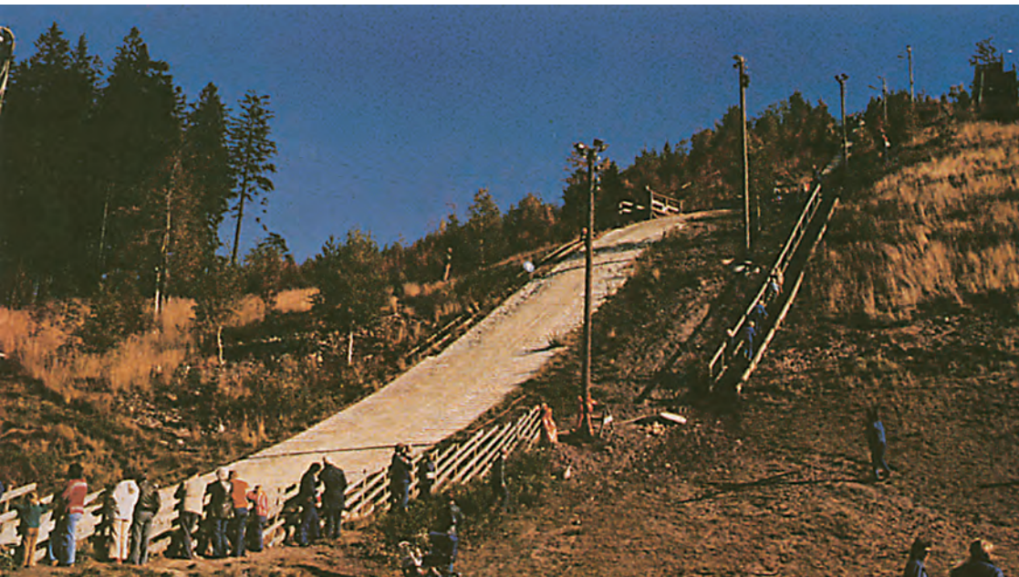
I 1976 ble det lagt plast i 40 metersbakken. Bildet er tatt i 1982. FOTO: Harald M. Nygaard/Historielaget
