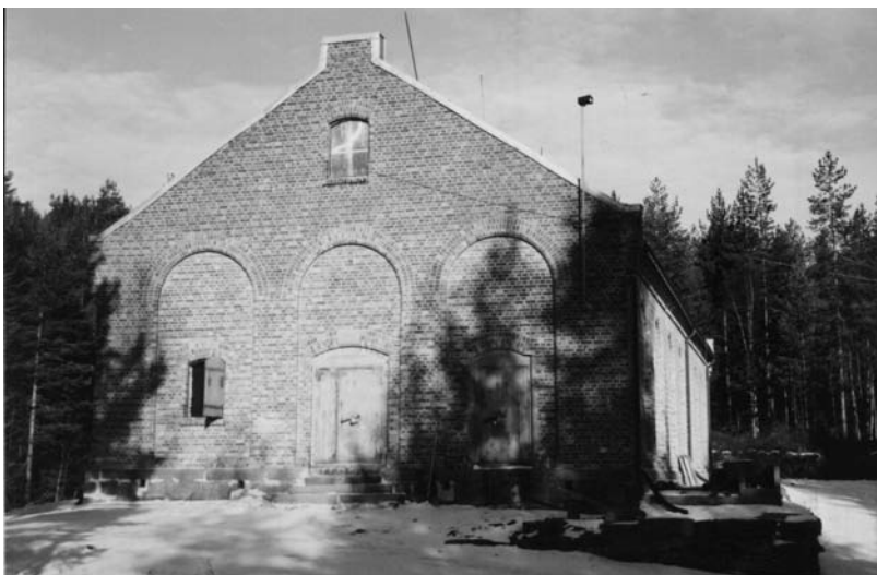
Kruttmagasinet fra 1876 (se kart) en kilometer sør for Kruttverket er en annen monumental bygning som er bevart fra Kruttverkets tid. Man tok ingen sjanser med kruttet: Rundt Magasinet var det byggeforbud i en radius på 567 meter. Foto: Iren Larsen
